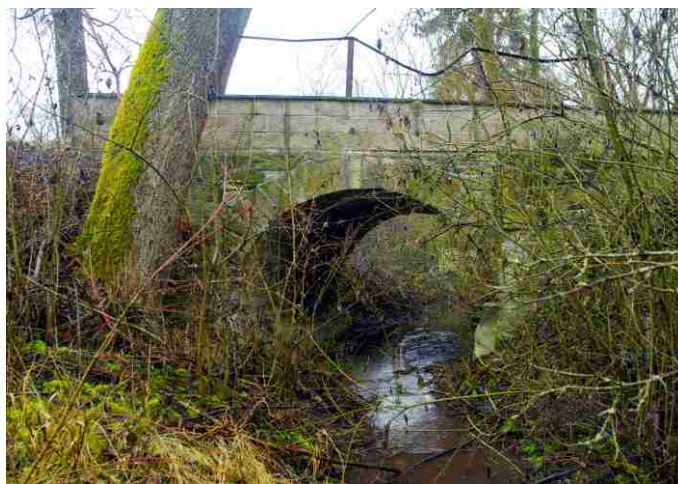
Mostek přes Podbradecký potok (13. 3. 2025), zřejmě totožný s mostkem z obrázku
