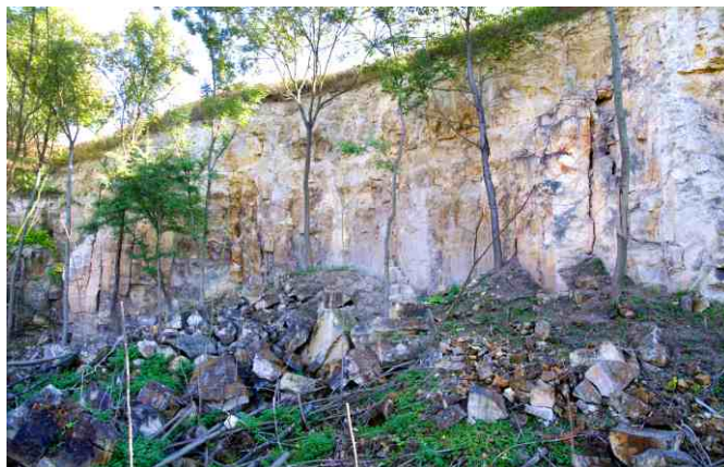
Opuková lomová stěna přímo u silnice z obce Hrádku.
