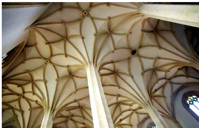
Kroužená klenba a sloupové z hrádecké opuky.
