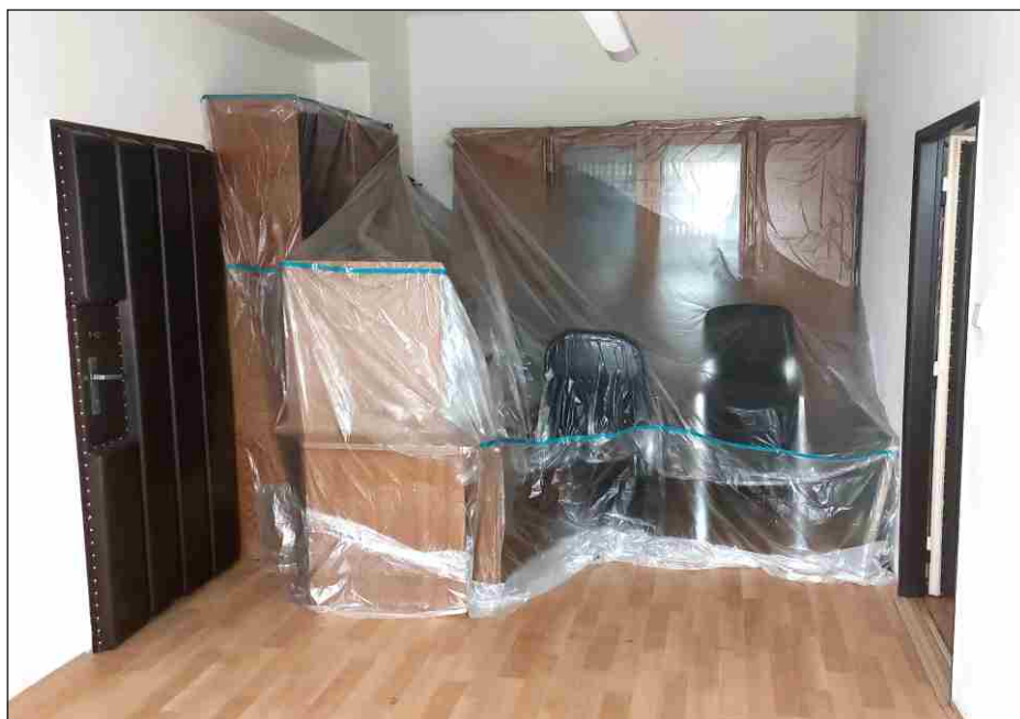
Probíhající stavební úpravy na městském úřadu.
