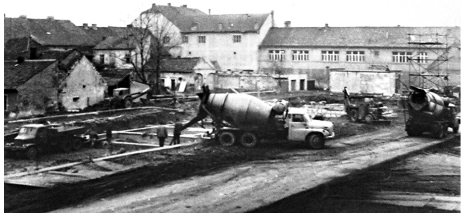
Stav po zbourání.
