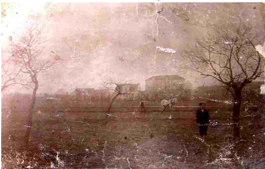
Obr. č. 2 - Nově postavená škola, pohled z městského parku, rok 1899.
