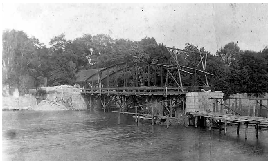
Obr. č. 2 - Stavba nového mostu v Libochovicích v r. 1897-8.
