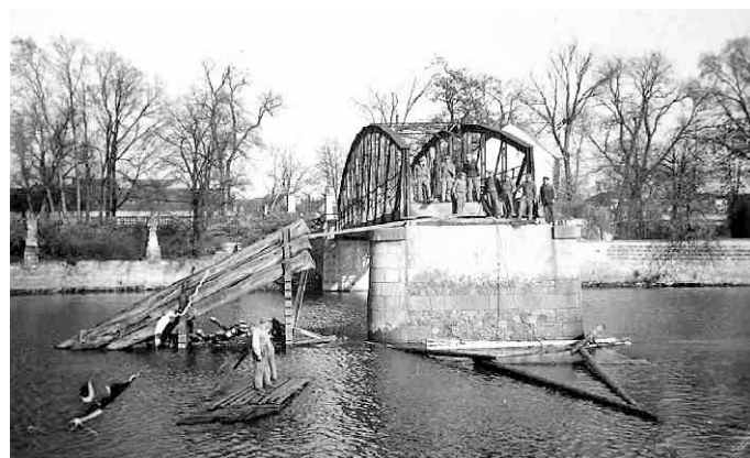
Obr. č. 9 - Rozebrání starého mostu r. 1939 firmou Šebek.
