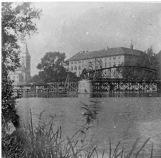
Obr. č. 4 - Stavba mostu v Libochovicích roku 1893.
